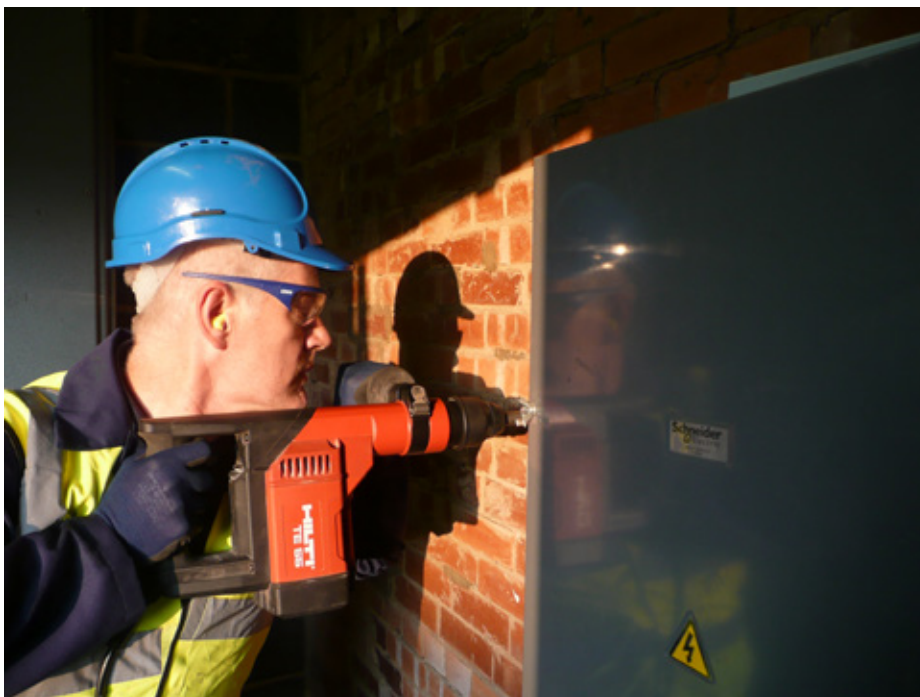
Figura 6.5 — Lavoratore con un utensile elettrico tenuto vicino al corpo. In questa situazione l'esposizione del corpo e degli arti è simile e la conformità ai LA inferiori/superiori è restrittiva
